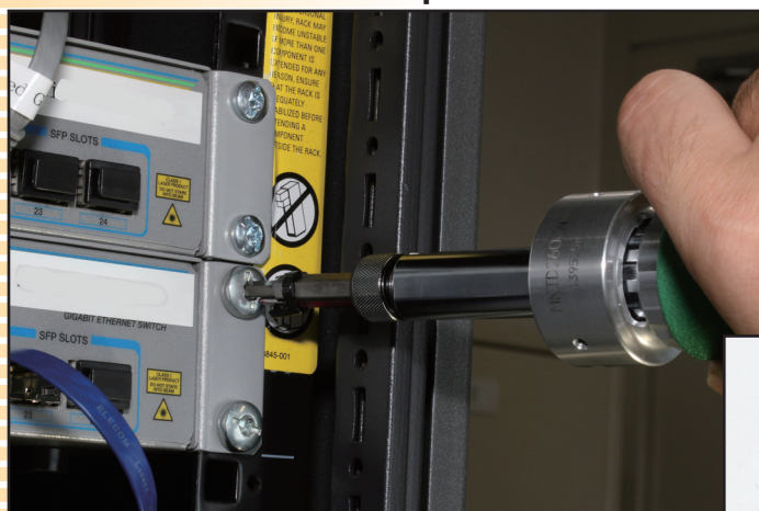
Tornillo con cabeza de fijación con marcador azul
